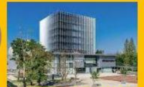
日本工業大学 5号館
